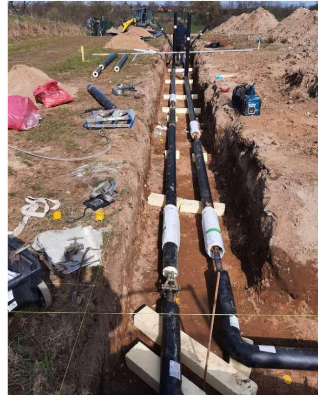
Aufbau Hydraulik (KMR) Solarthermie Anlage
